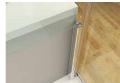
Detail napojenia skrátenej bočnej steny k vani
